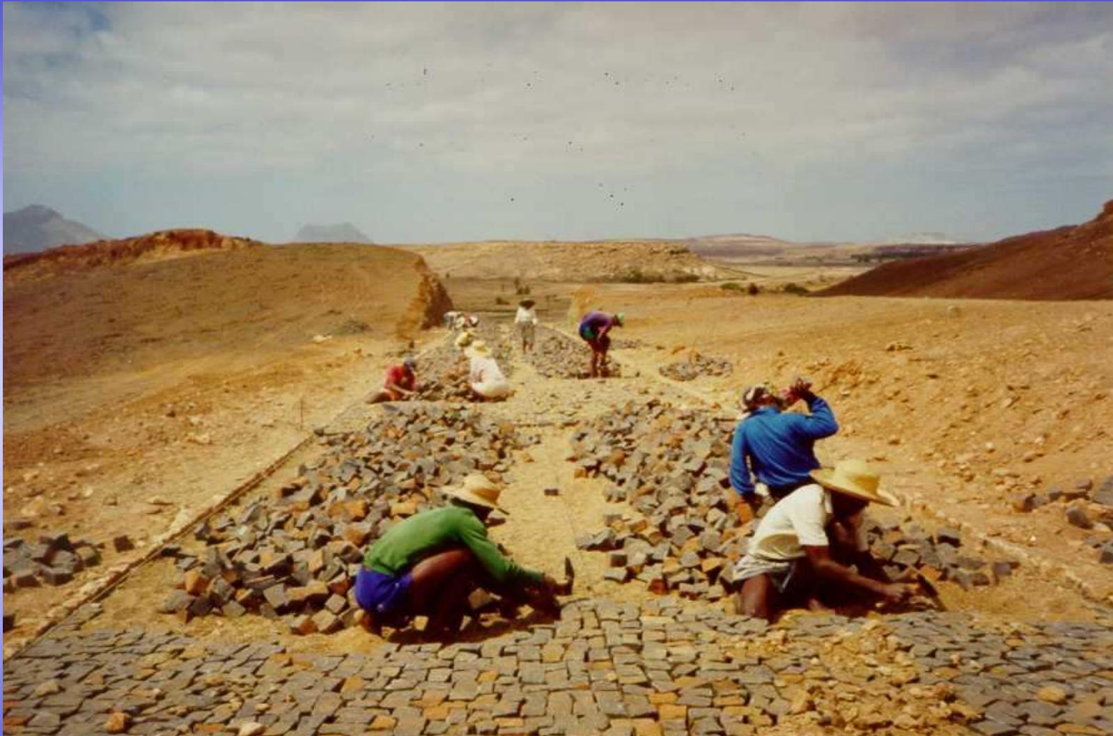
Construção do troço de estrada Ligação da povoação de Rabil à de Instancia de Baixo 5
